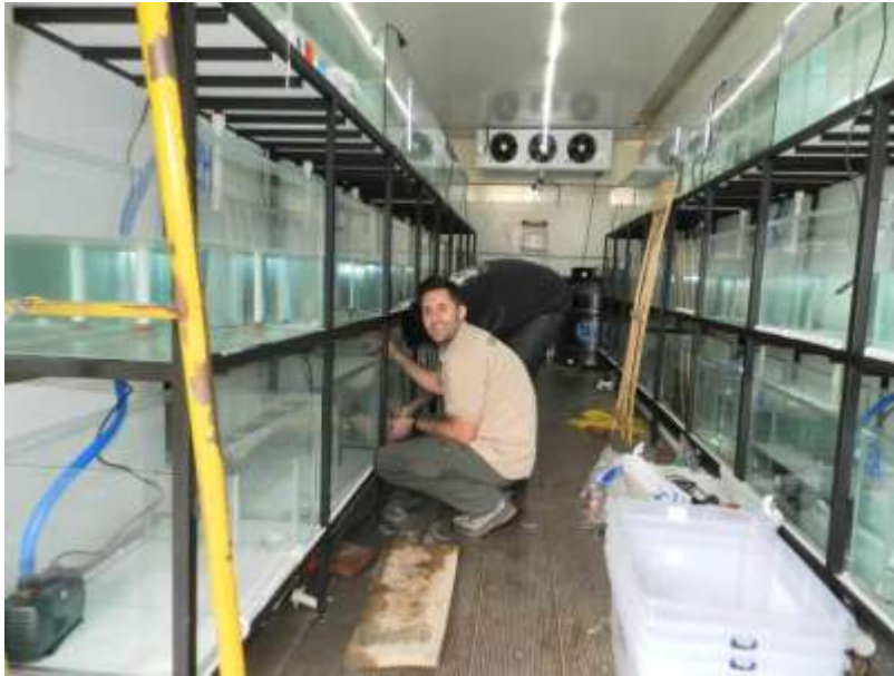
Fig. 11. Finalización del sistema de desagüe interno de los sistemas de acuarios.
