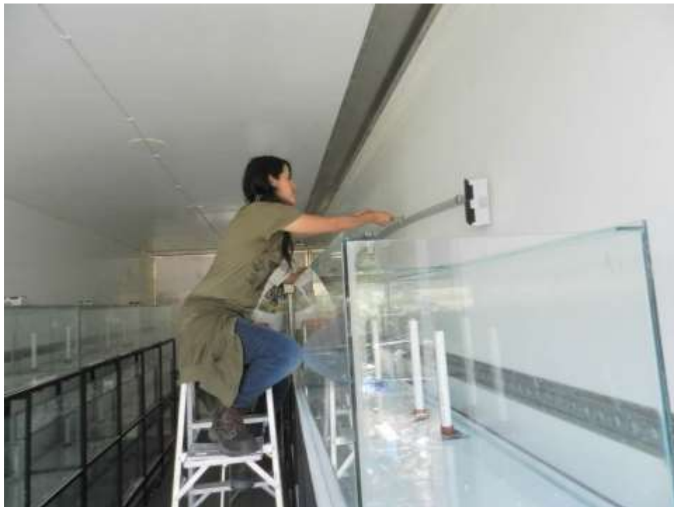
Fig. 8. Instalación del sistema eléctrico al nuevo container.
