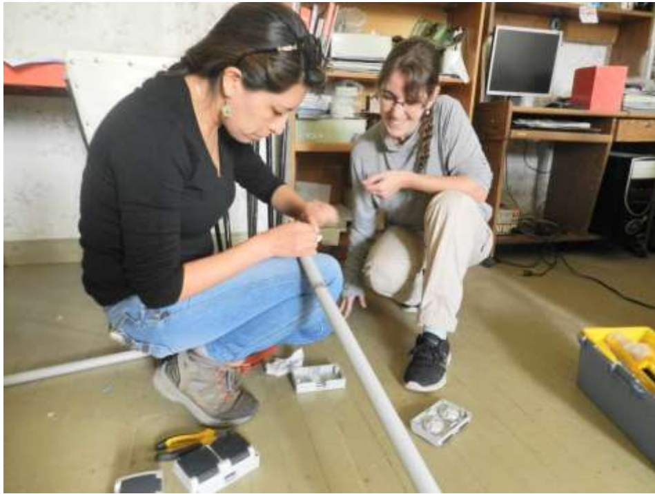
Fig. 7. Preparación de tubería para sistema de electricidad para nuevo container.
